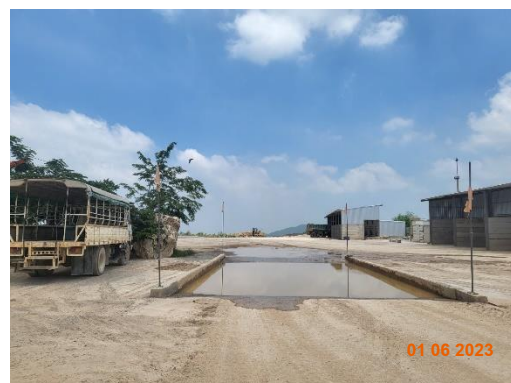
รูปที่ 2-17 บริเวณสำหรับการทำความสะอาดเศษดิน เศษโคลนที่ติดตามรถบรรทุกแร่
